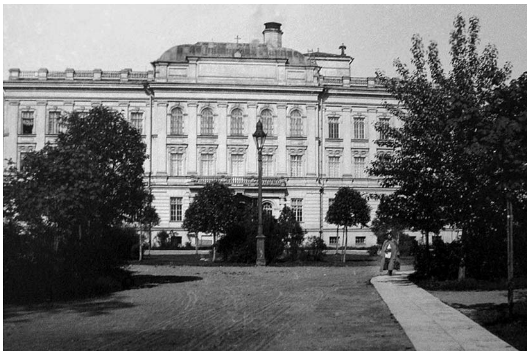
Рис. 29. Фасад главного здания клиники душевных и нервных болезней
