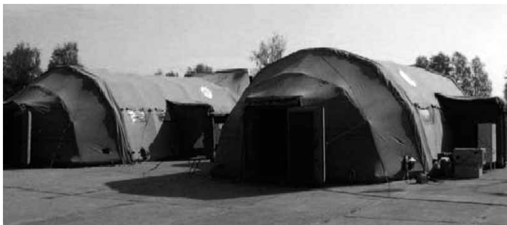
Рис. 2. Пневмокаркасное сооружение ПСМ-6 с внутренним каркасом (Россия)
